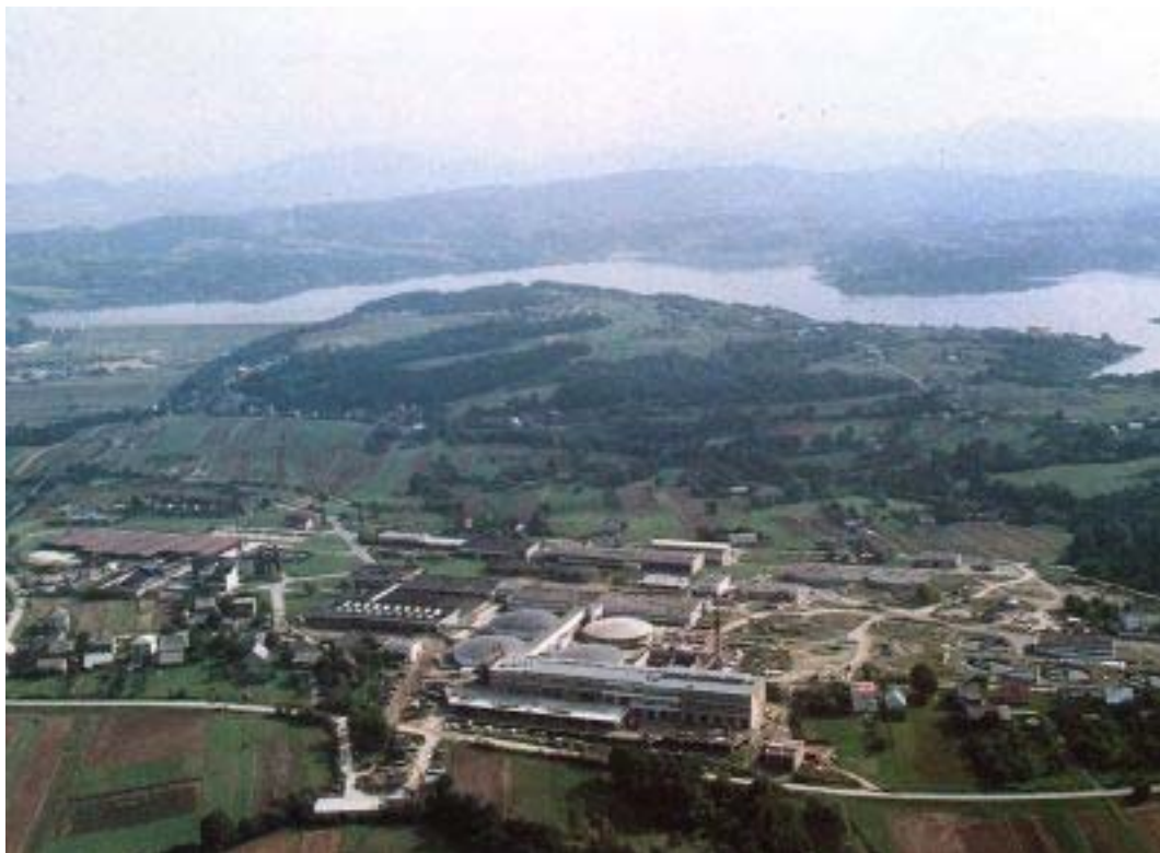
Rys.2 Zakład Uzdatniania Wody Raba [9].
